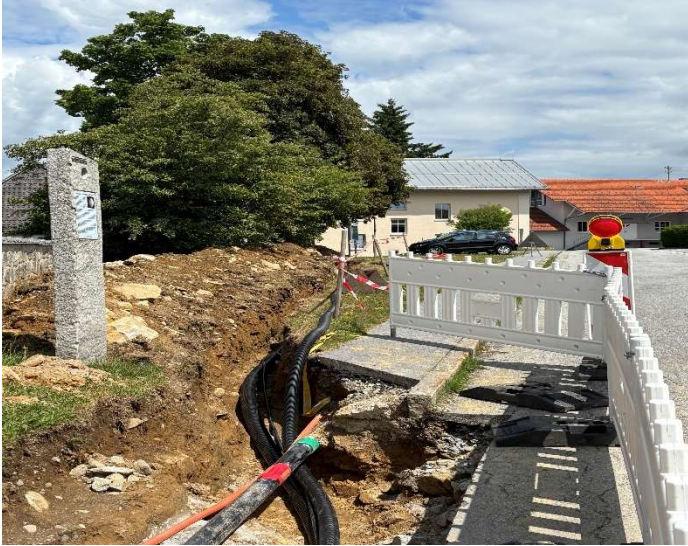
Verlegung der neuen Fernwärmeleitung zum Rathaus
