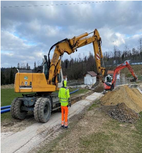
Verlegung der neuen Wasserleitung (Ringschluss)
